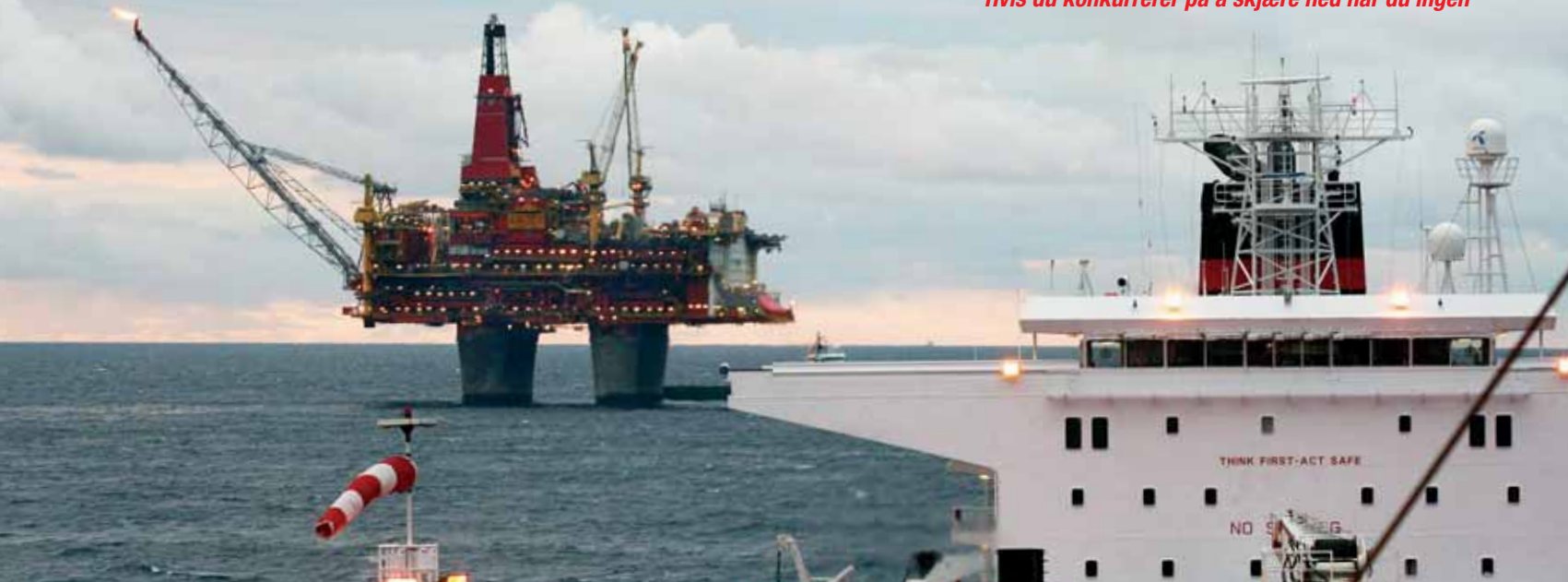
M/T Tordis Knutsen på Statfjord-feltet. Haugaland Brannsikring er leverandør til både StatoilHydro og Knutsen OAS Shipping. Foto: Odd-Atle Urvik
