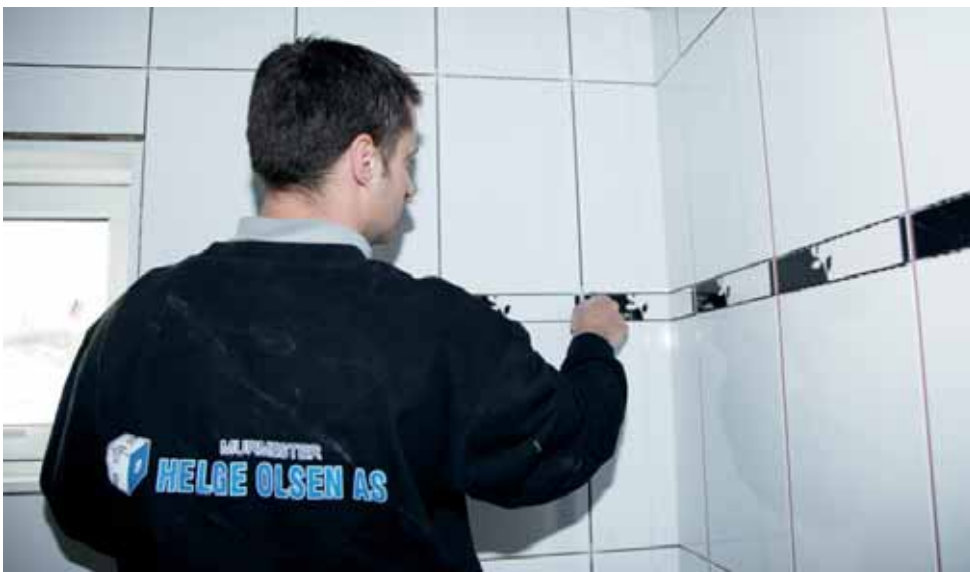
Flislegging av baderom på Uvikstrand for Saga Bygg.
