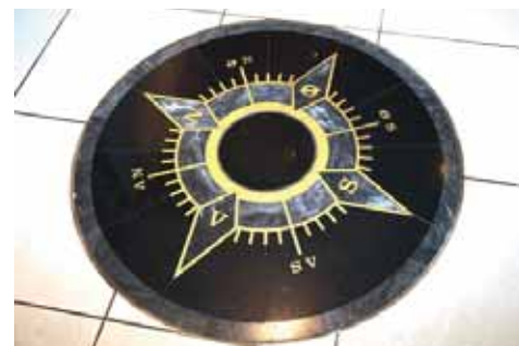
Flisarbeid muliggjør spesielle detaljer. Denne kompassrosen er lagt inn i gulvet på Rica Maritime.
