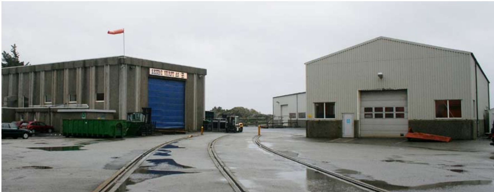
Skude Verft AS har omstilt seg fra å være et rent reparasjonsverksted for skip til å ha 80 prosent av aktiviteten rettet inn mot subsea- og offshoremarkedet. Til høyre maskinverkstedet og rørhallen. Den store bygningen til venstre er platehallen. Foto: Odd-Atle Urvik
