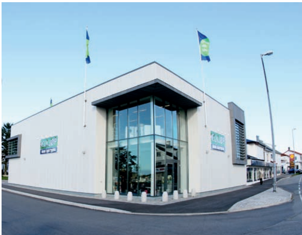
Nybygget til Åkra Elektriske er et av byggene som er laget av betongelementene fra Finnøy Betong.
